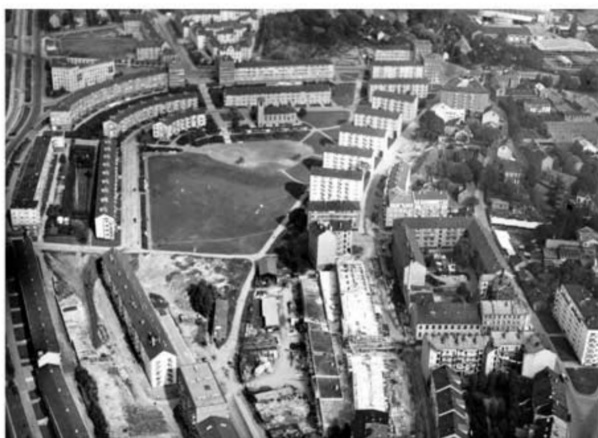
Flyfoto av Ila olympiakvarter i Iladalen.
