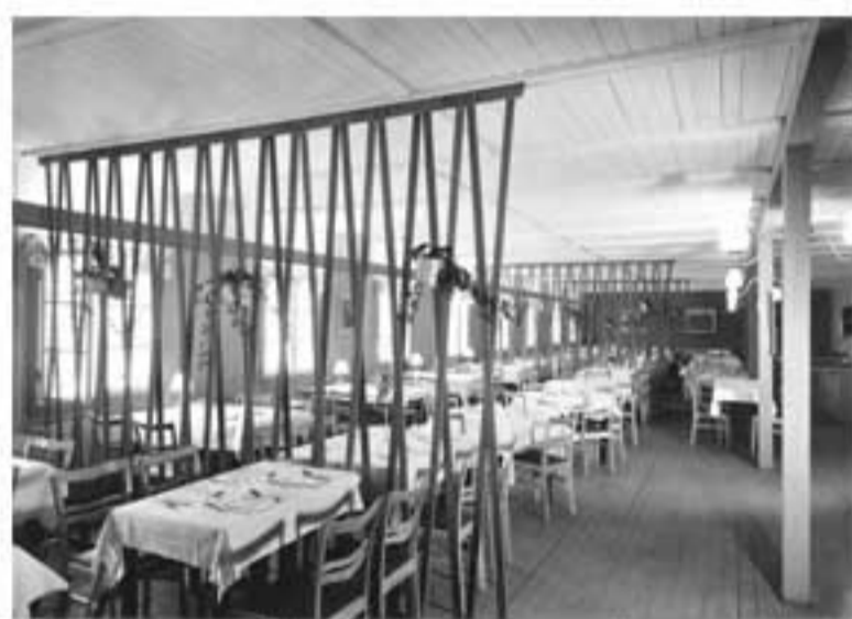
Matsal i provisorisk enetasjes bygning ved stjerneblokkene på Ullevål olympiakvarter.
